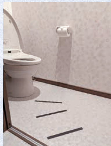
写真1 トイレ床の目印テープ トイレのスペースに合わせて、緩やかに曲がれるようにテープを貼付する。
