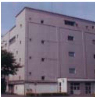
建物の耐震補強
